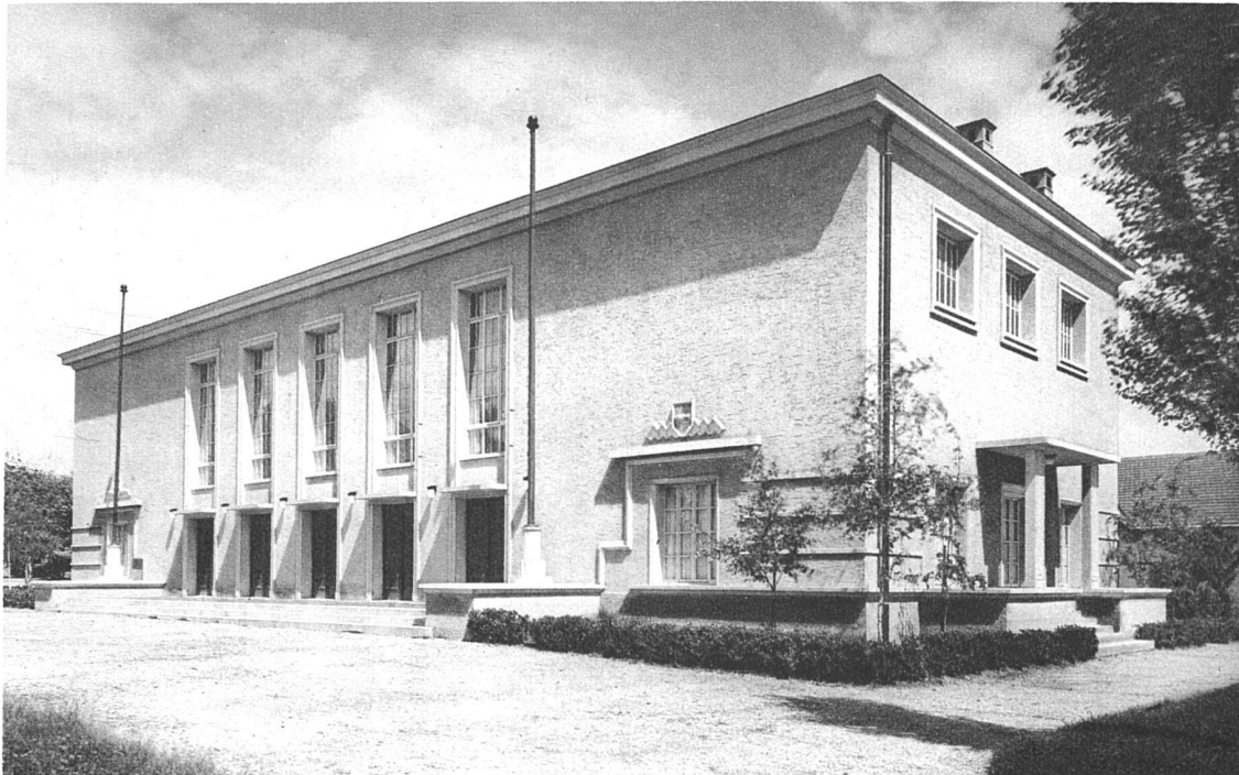
Façade sud-ouest, donnant vers le parc Salle communale de Nyon (Vaud) Alphonse Laverrière, architecte FAS, Lausanne
