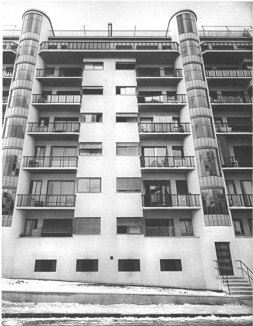
Façade postérieure avec les cages d'escalier
