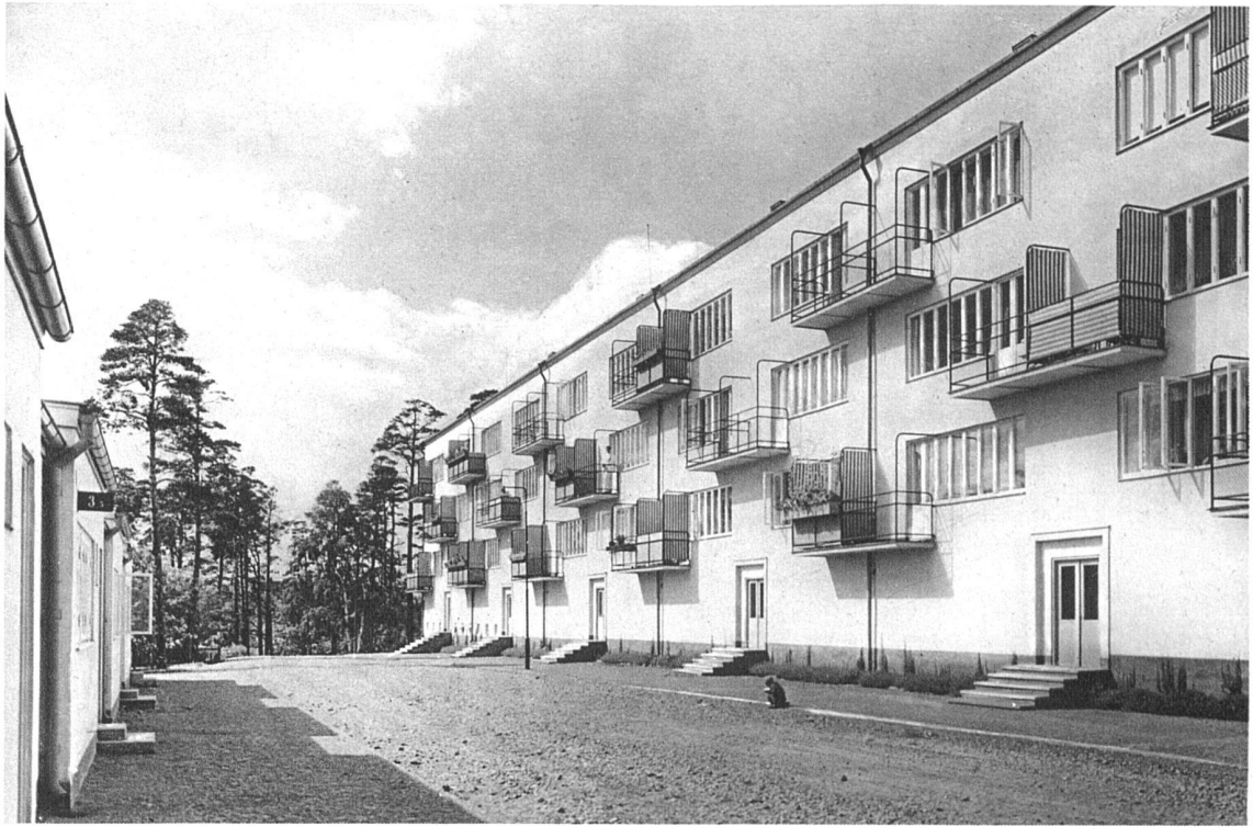
Die dreistöckigen Reihenhäuser aus Südosten gesehen
