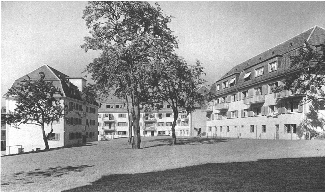
Siedlung Geibel-Rosengartenstrasse, Zürich 6, aus Osten
