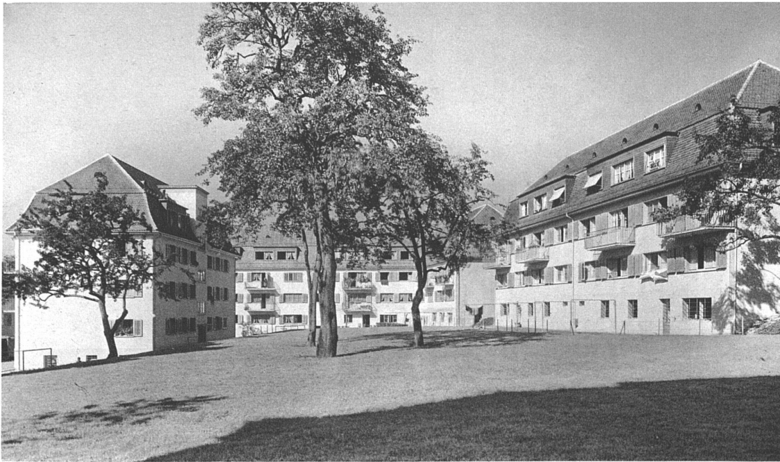
Siedlung Geibel-Rosengartenstrasse, Zürich 6, aus Osten
