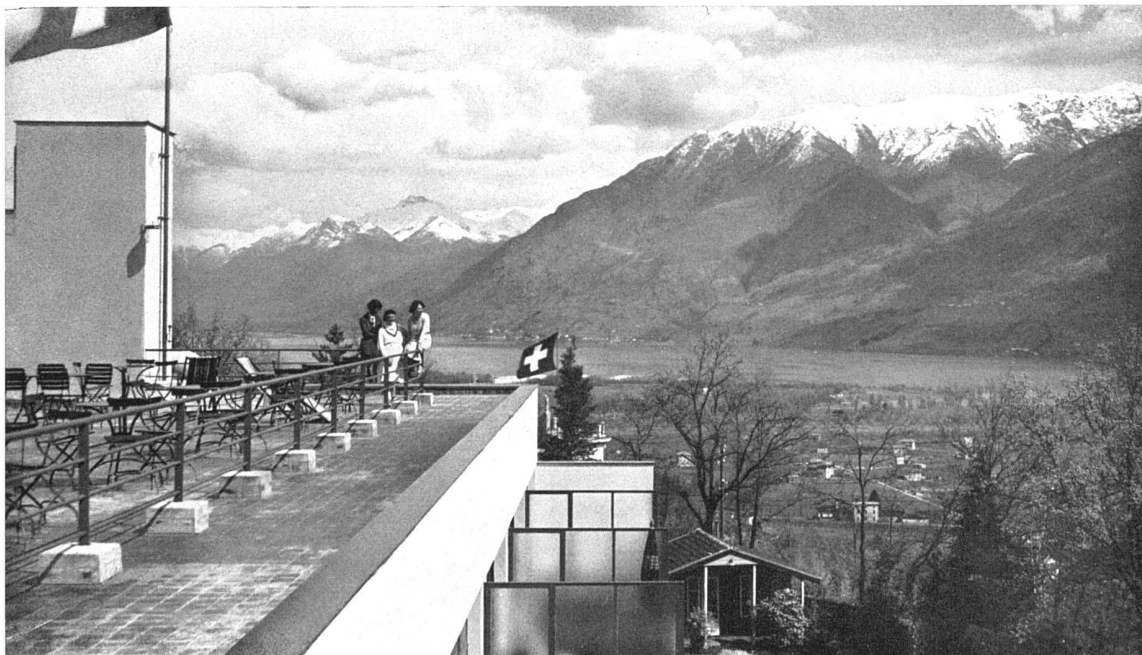
Dachterrasse, Blick nach Osten gegen Magadino, rechts Monte Tamaro, in der Ferne Camoghe
