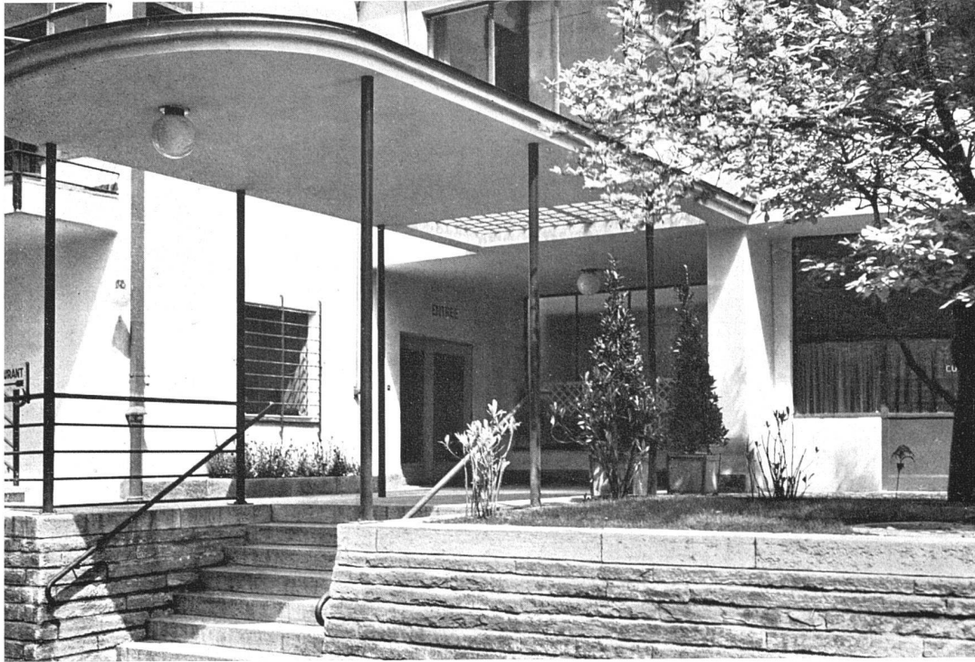
Zugang und Vorhalle im Untergeschoss, Ostseite des Hauptbaues
