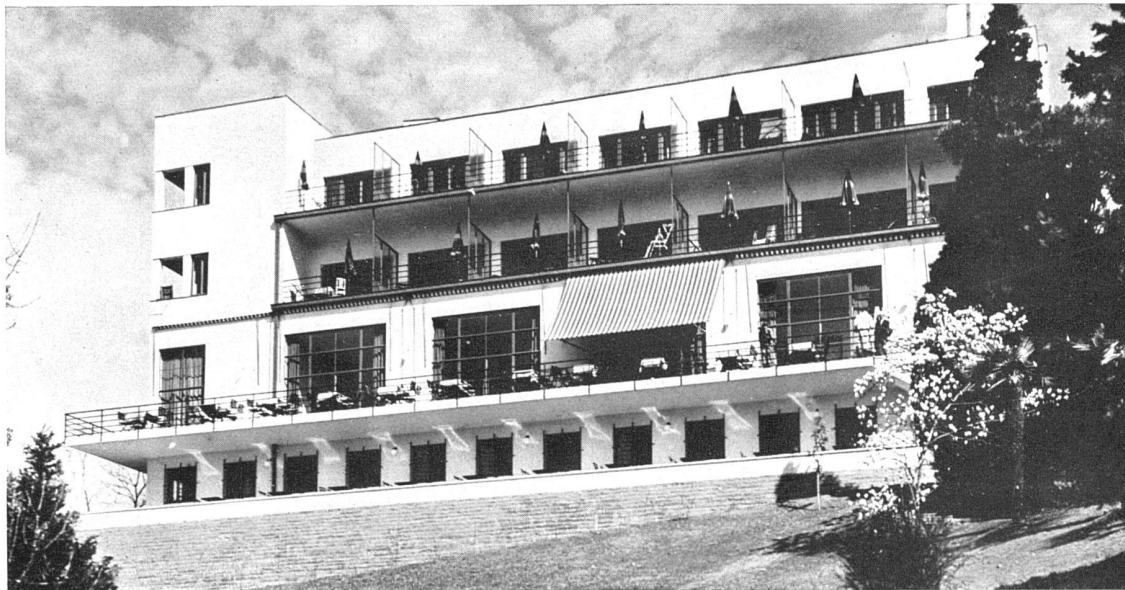
Kurhotel Monte Verità, Ascona (Tessin) Südseite Architekt Prof. E. Fahrenkamp, Düsseldorf; örtliche Bauleitung Architekt O. Roelly, Ascona
