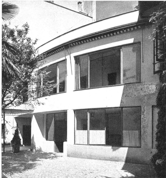
Verbindungsbau zum alten Hotel im Untergeschoss, links Vorhalle
