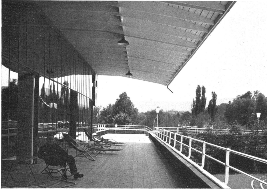
Zürcher Gartenbauausstellung «Züga» Carl Egender, Wilhelm Müller, Architekten BSA, Zürich, und Ing. Kägi in Firma Locher & Co., Zürich Halle 1, Verglasung in handelsüblichem Normalformat, mit Bleistreifen, also kein Glasverschnitt Die Scheiben werden nach Gebrauch vom Lieferanten zurückgenommen
