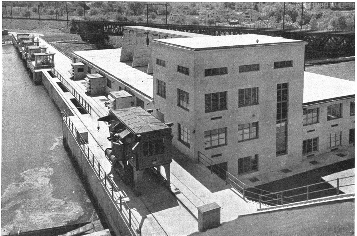
Stauwehr und Maschinenhaus, Oberwasserseite Ansicht aus Nordwesten
