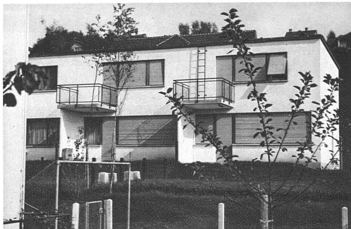
Ansichten aus Südwesten und Süden
