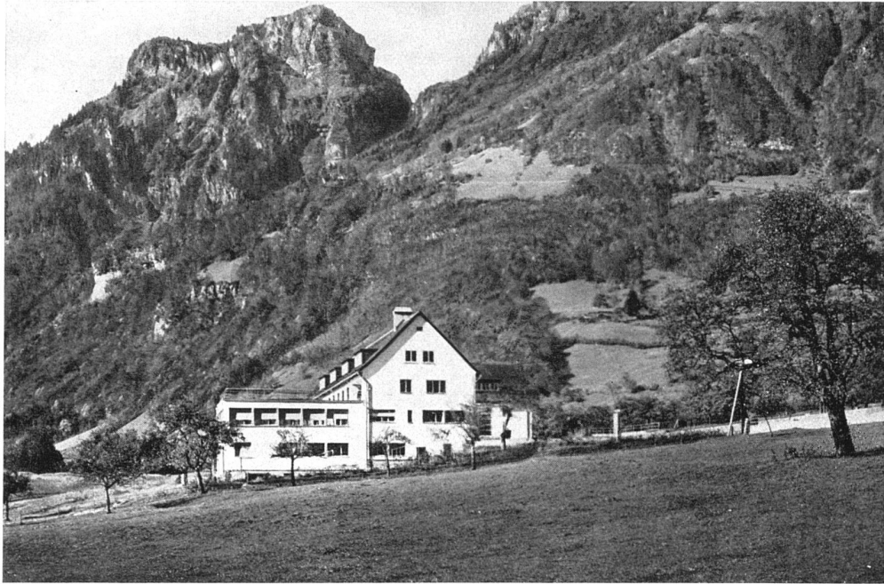
Ansicht aus Nordosten
