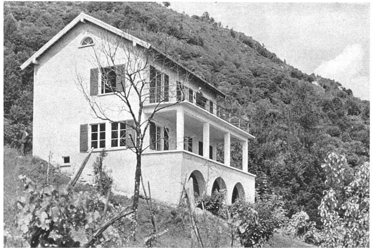
Ansicht aus Südwesten. Das Haus wurde 1931 bezogen. Baukosten Fr. 38.40 pro m 2
