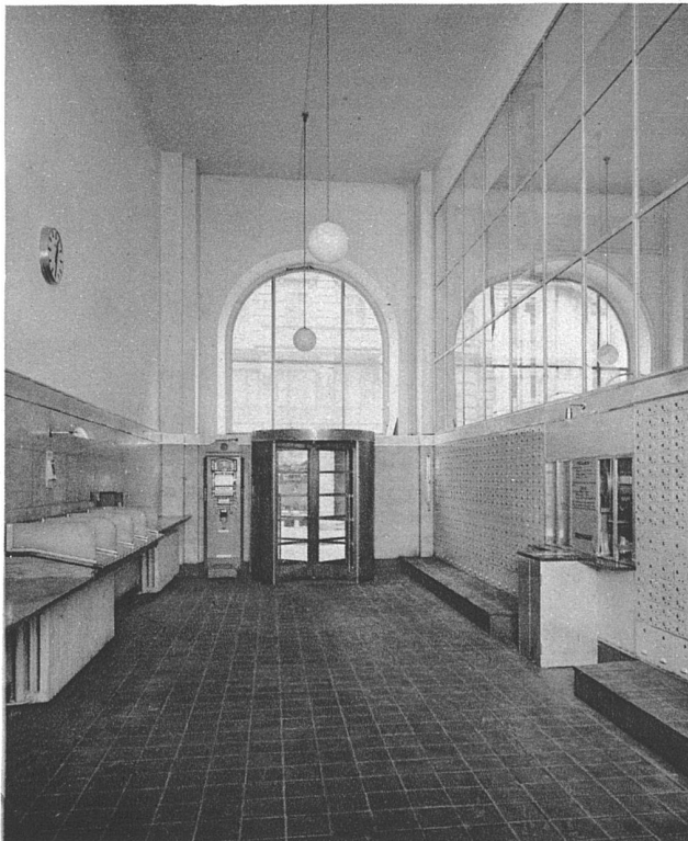
Schlossfächerraum an der Fraumünsterstrasse 1100 Fächer (früher 500). Wandverkleidung in römischem Travertin und Anticorodal
