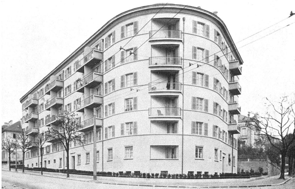
Vue de sud-ouest angle de l'avenue de La Harpe et de l'avenue des Jordils
