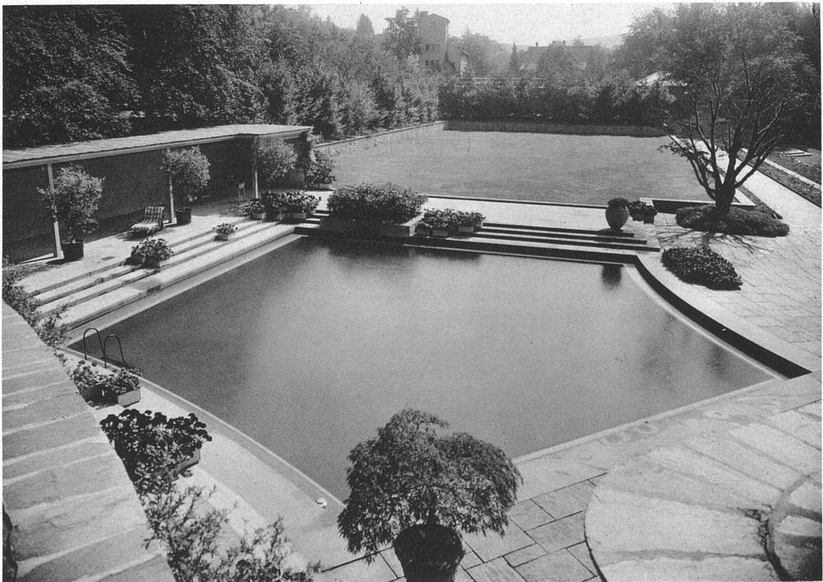
Das Schwimmbassin mit Wandelhalle vor dem Ostgiebel
