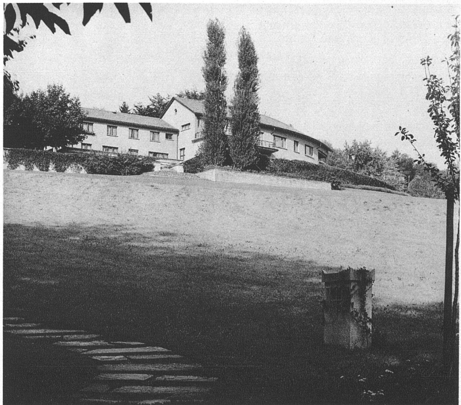
Ansicht von Südwesten, links Küchentrakt und Angestelltenzimmer
