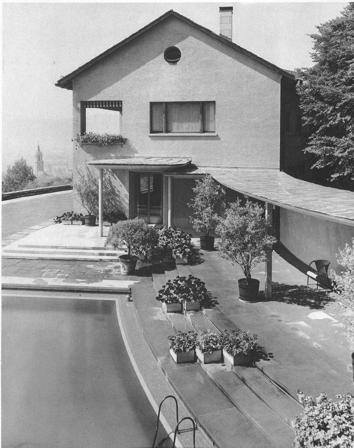
Oestliche Schmalseite, Wandelhalle und grosses Bassin (Eisenbeton mit Mosaikverkleidung) Terrassenbelag in Sandsteinplatten, Wandelhalle ebenso wie das Hausdach gedeckt mit Platten aus Malencogranit, bei letzterem über Schindelunterzug. Sparrenvordach des Hauses in Eichenholz geräuchert, Fenster in Eichenholz geräuchert, mit Ausnahme der Metallschiebefenster und -türen im Erdgeschoss. Spenglerarbeiten in Kupfer. Steinhauerarbeiten am Wohnhaus in Sandstein geschliffen, an den übrigen Bauten in Kunststein
