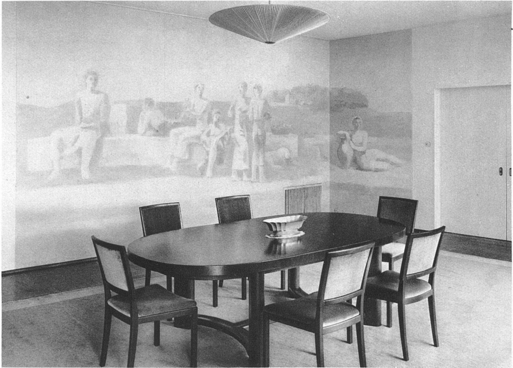
Grosses Esszimmer mit den Wandmalereien von Karl Walser (Oelmalerei auf Sperrholzplatten), siehe «Werk» Nr. 1, 1934. Als Bodenbelag Nussbaumparkett. Metalltüren gegen die Terrasse matt vernickelt. Luftheizung
