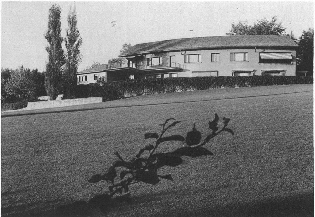
Ansicht aus Süden
