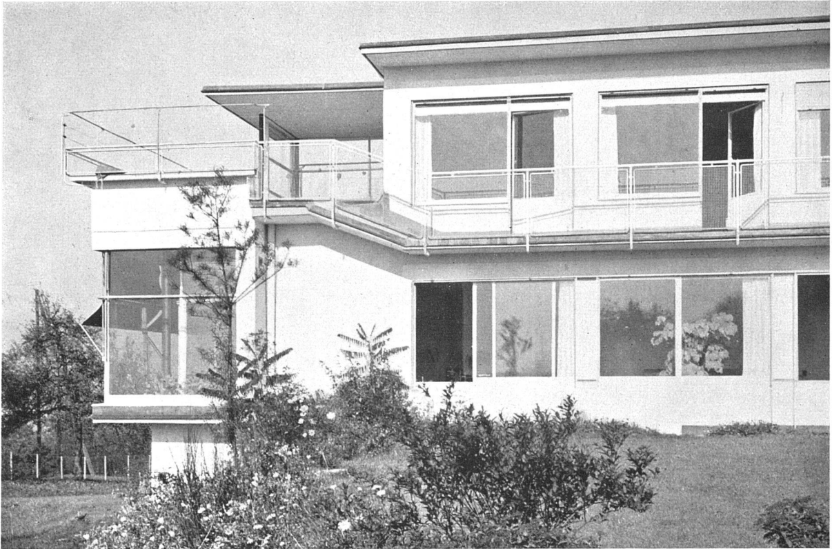
Teilansicht der Südostfassade, links das grosse Blumenfenster; der südwestliche Teil des Wohnzimmers ist 40 cm höher als die anderen Erdgeschossräume, deshalb die Differenzstufen im Laubengang des Obergeschosses
