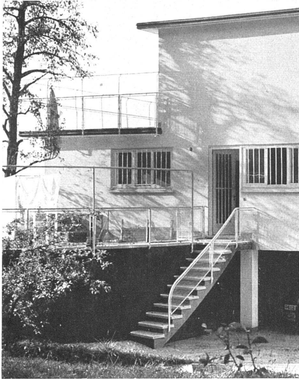
Lieferanteneingang in der Nordostfassade
