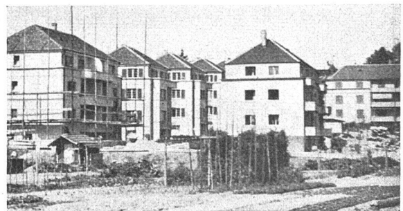
Mietbautengruppe im Länggass-Brückfeldquartier — Gewissermassen Mansardendächer, die steile untere Dachfläche ersetzt durch zurückgesetzte senkrechte Wände. Ein Bastardprodukt, wie es auch in andern Städten vorkommt, erstanden aus der richtigen Erkenntnis, dass ein Mansardengeschoss ohnehin ein Vollgeschoss ist und besser gleich als Vollgeschoss ausgebaut würde, wobei man erst noch den Vorteil ruhiger Dachflächen gewinnt. Das «ausgebaute Dachgeschoss» wäre also ersetzt durch ein Vollgeschoss — aber die Zonenbauordnung erzwingt das Zurücksetzen dieses Geschosses, wobei die Bauten dann doch wieder die pastetenhafte Klotzigkeit bekommen, wie die Häuser mit normalen Mansardendächern
