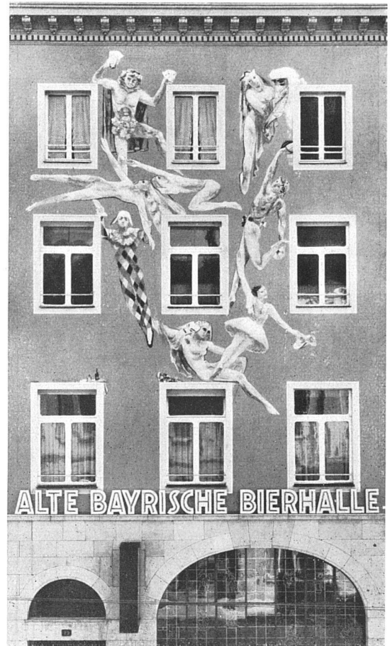
Die «Alte Bayrische Bierhalle», Basel, nach dem Umbau Bräuning, Leu, Dürig, Architekten BSA, Basel
