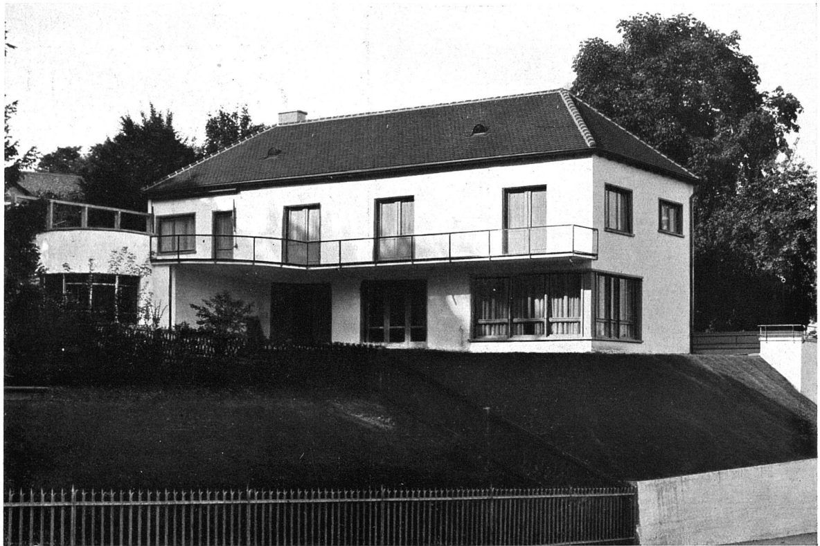
Ansicht aus Südosten
