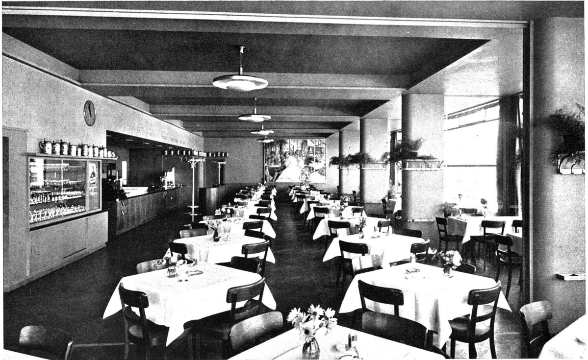
Speiserestaurant im I. Stock, an der Stirnwand Gemälde von Max Gubler, Zürich Eine innere Treppe sowie ein ganz mit Quarzitplatten ausgekleidetes Treppenhaus führen vom Bahnhofplatz aus zum Lokal im I. Stock, das durch die Schiebewand unterteilbar ist. Es ist in lichten Tönen abgestimmt. Anschliessend ein «Braumeisterstübli» mit Emblemen aus dem Brauergewerbe
