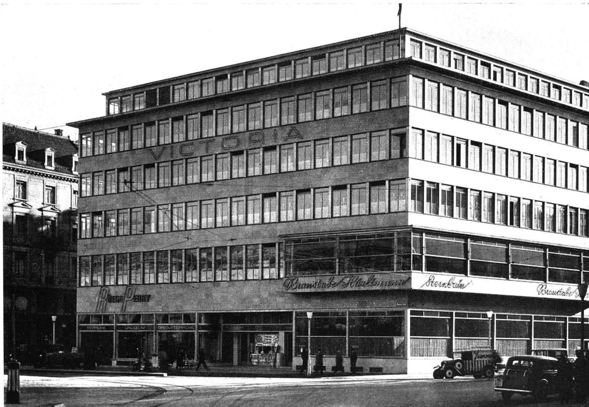
Ansicht aus Norden. Ecke Bahnhofplatz-Löwenstrasse
