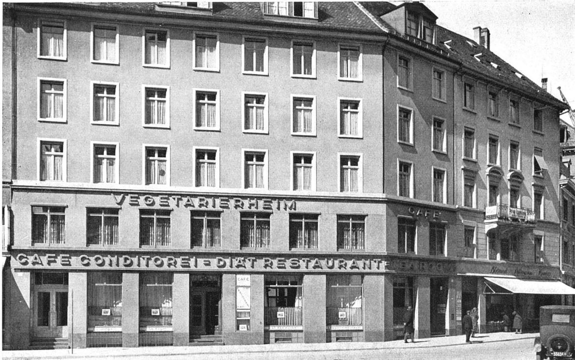
Zwei ursprünglich selbständige Häuser waren durch den Umbau zu einer Einheit zu verschmelzen. Der Restaurantbetrieb im Erdgeschoss und I. Stock ist auch äusserlich durch die Fassadenverkleidung in Basaltlitzkunststein kenntlich gemacht. Obergeschossfassade in Edelputz
