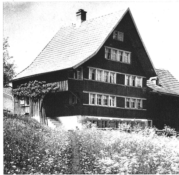
oben: «Tätschhaus» mit Giebelfront, links Schirmwand unten: Steiles Dach; weisse Fenster im braunen Holzwerk
