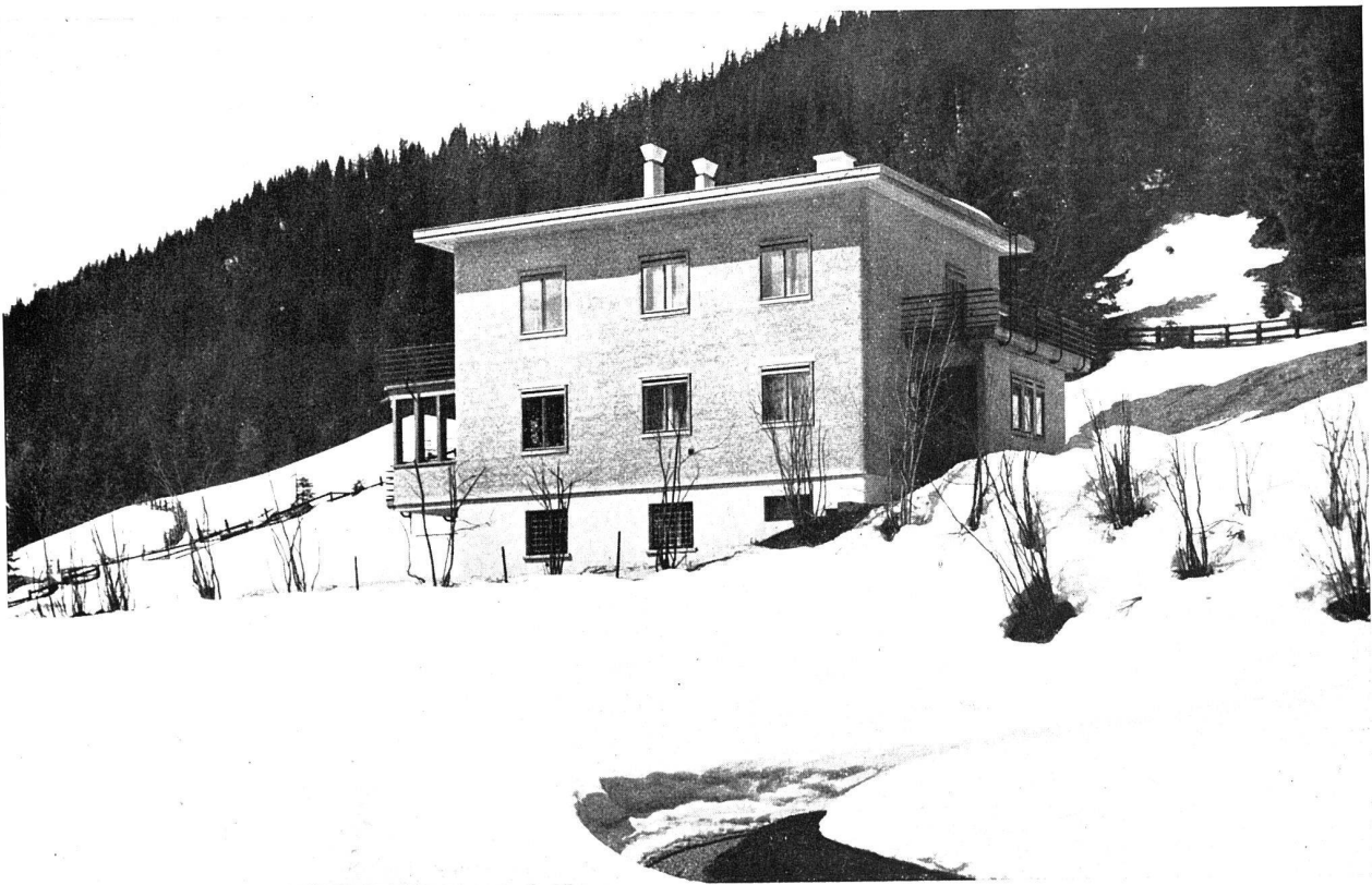
Ansicht aus Nordosten
