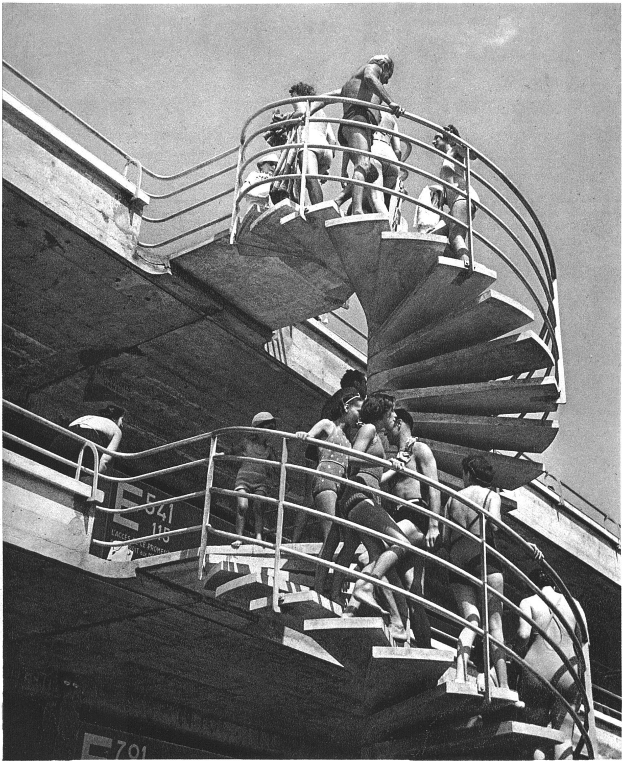
Un des trois escaliers extérieurs en colimaçon du solarium — Eine der drei äusseren Wendeltreppen zur Sonnenbadterrasse La Plage de Bellerive à Lausanne Architecte Marc Piccard FAS, Lausanne
