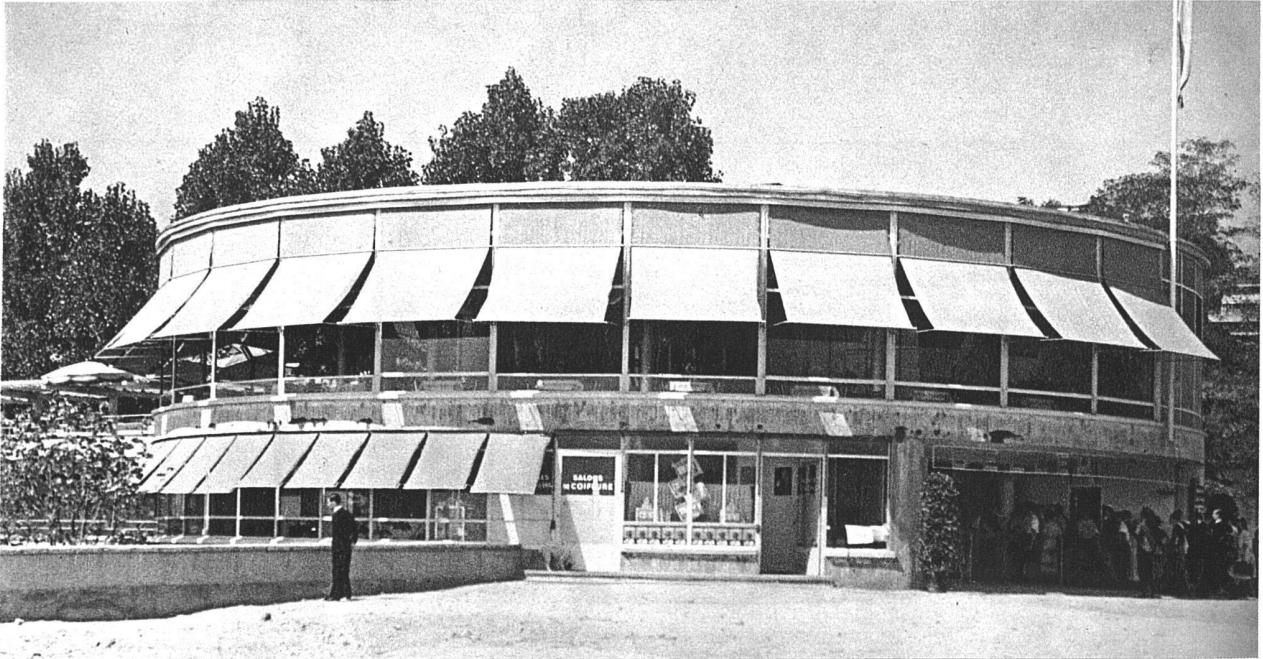
La Rotonde. Au rez-de-chaussée: buvette et caves; au 1er étage: entrée, services généraux, magasin de tabacs, journaux, salon de coiffure, etc. au 2 me étage: cuisines et restaurant, se prolongeant sur la terrasse du solarium
