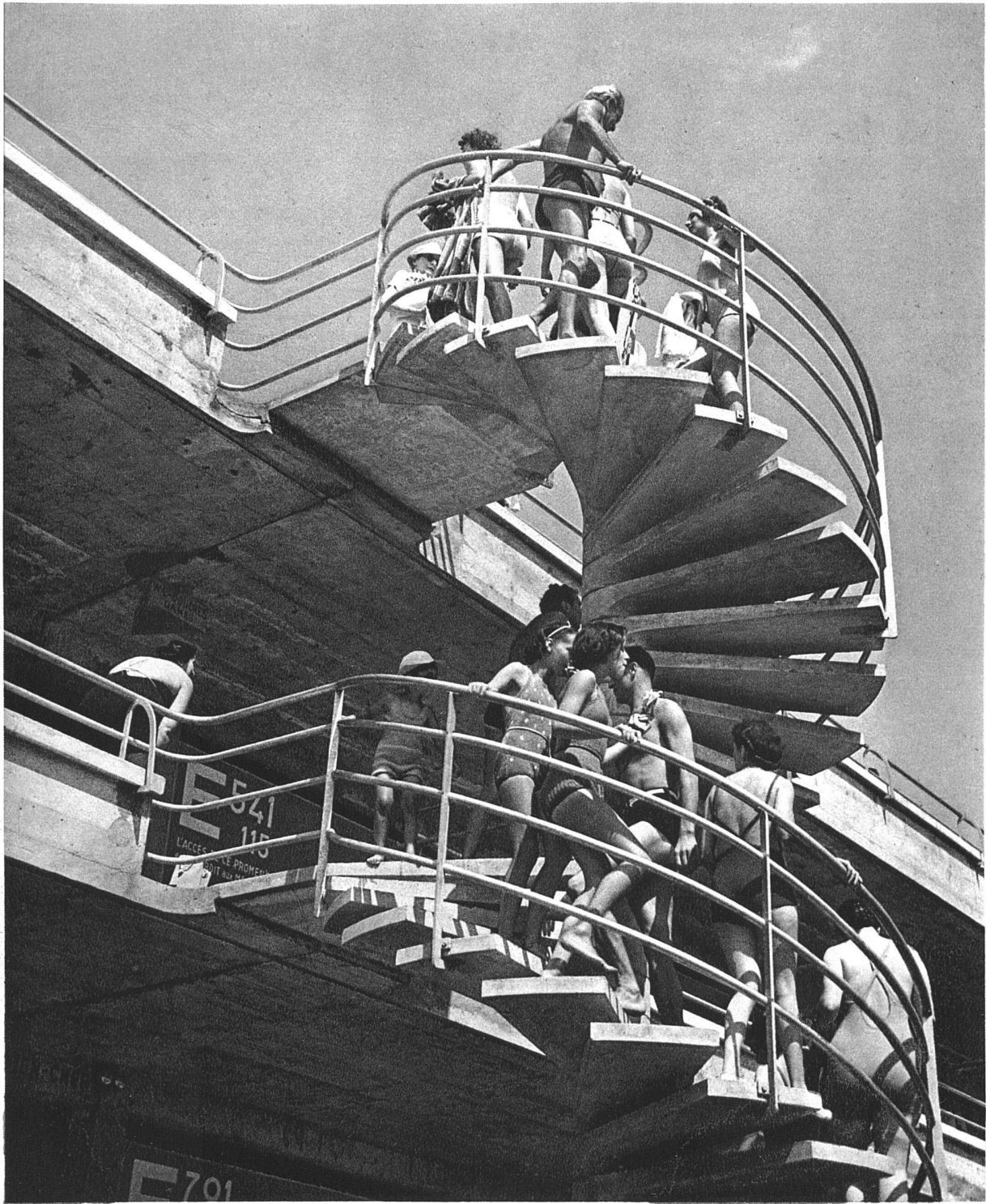
Un des trois escaliers extérieurs en colimaçon du solarium — Eine der drei äusseren Wendeltreppen zur Sonnenbadterrasse La Plage de Bellerive à Lausanne Architecte Marc Piccard FAS, Lausanne
