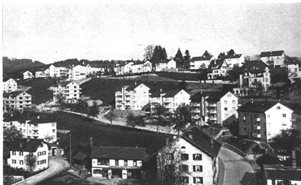
rechts nebenstehend: Luzern, südl. Stadttteil. In der Bildmitte Wohnkolonie Breitlachen der Allg. Baugenossenschaft Luzern, 1932. Arch. Schärli und Mozzatti
