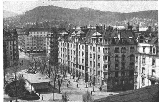
Offene Bauweise — ohne zulängliche Bauvorschriften
