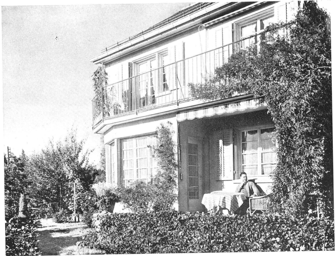
Zweifamilienhaus E. M. und Einfamilienhaus J. R. an der Enzenbühlstrasse, Zürich, erbaut 1927/28 Gebrüder Bräm, Architekten BSA, Zürich
