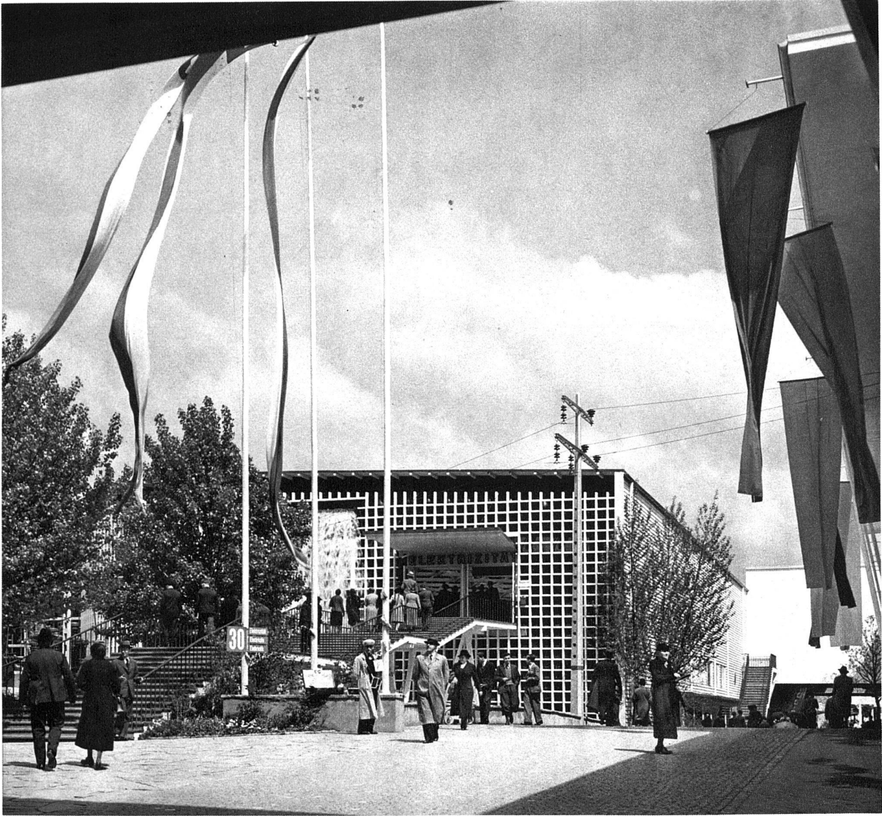
Abteilung «Elektrizität». Architekt Dr. Roland Rohn BSA, Zürich. Pavillon «Wasserkraft» mit dem 9 m hohen Wasserfall
