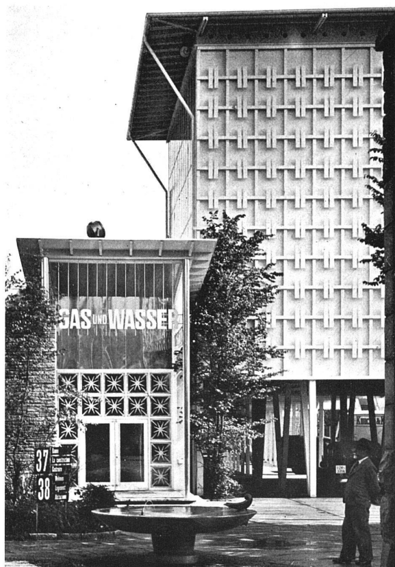
Oberflächen-Texturen von deutlich ornamentalem Charakter an einem Teil der Höhenstrasse (rechts). Man beachte, die Wände sind als selbständige Ebenen behandelt und durch eine neutrale Zone vom Dach getrennt.
