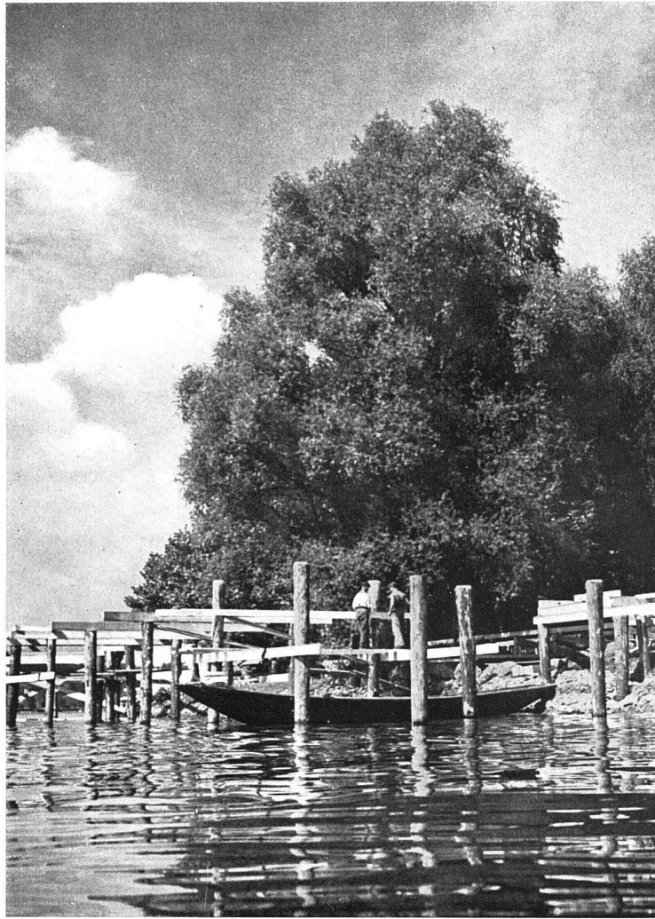
Pfahlrost der «Chüechlistube» am Zürichhorn
