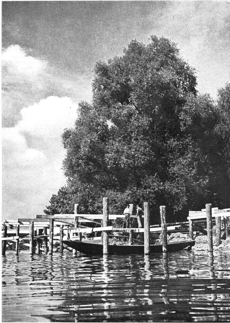
Pfahlrost der «Chüechlistube» am Zürichhorn
