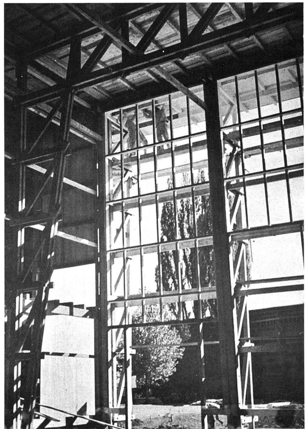
Detailansicht der Halle der Elektrizität
