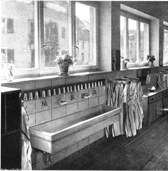
Kindertagesgebäude Rebhügel Vorplatz im Obergeschoss, mit Waschgelegenheit
