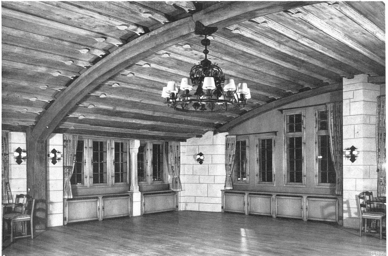
Die «untere Stube» des «Rüden», seit dem Umbau 1936/37, mit der wieder freigelegten originalen spätgotischen Holzdecke von ca. 1500
