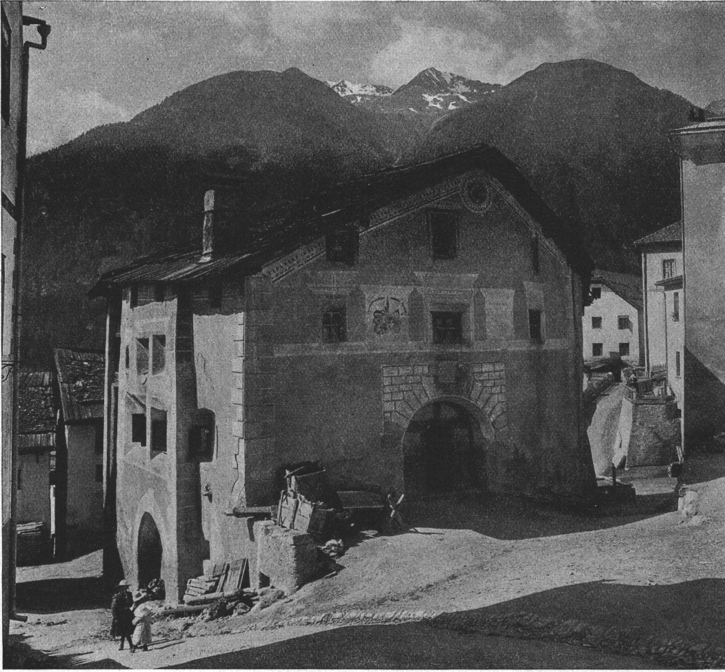
Ardez, Unterengadin. Haus ehemals Koenz. Ueber dem Torbogen Wappenstein und gemaltes Wappen des Jacob Simon Koenz, 1676. Typisches Engadiner Haus mit Sgraffitoschmuck; rechts durch das Hauptportal Einfahrt in den Sulèr, um den die Wohnräume gruppiert sind; links, ein Geschoss tiefer, Einfahrt in die Cuort mit Keller und Stallungen
