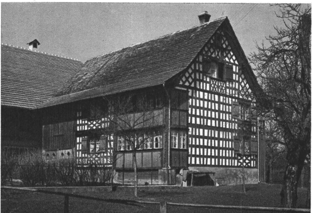
Wohnhaus bei Muolen, St. Gallen. Sichtbarer Riegelbau, nur in Gegenden mit geringer Niederschlagsmenge möglich (1,2 m)
