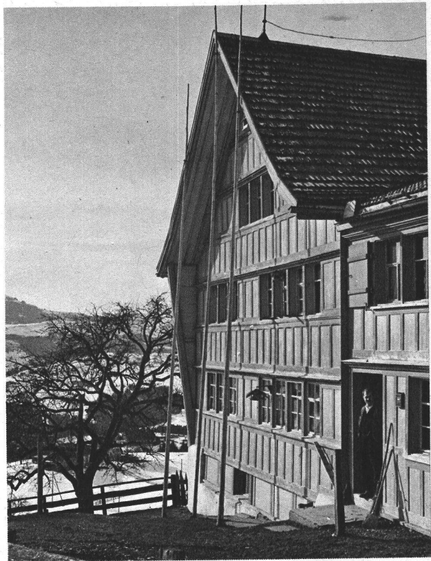
Südfront eines Hauses in Teufen, Appenzell, mit Windschutzwand und Windstangen
