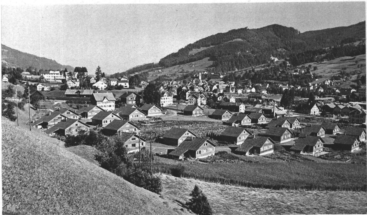
Ansicht aus Süden
