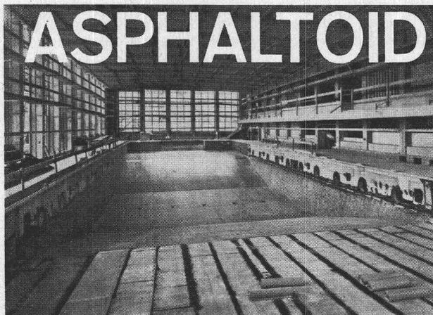
Hundertfach erprobt zur Abdichtung von Bassins, Brücken, Tunnels, Flachbedachungen, Terrassen. Asphaltoid, die elastische Isolierplatte mit imprägnierter Gewebeeinlage.
