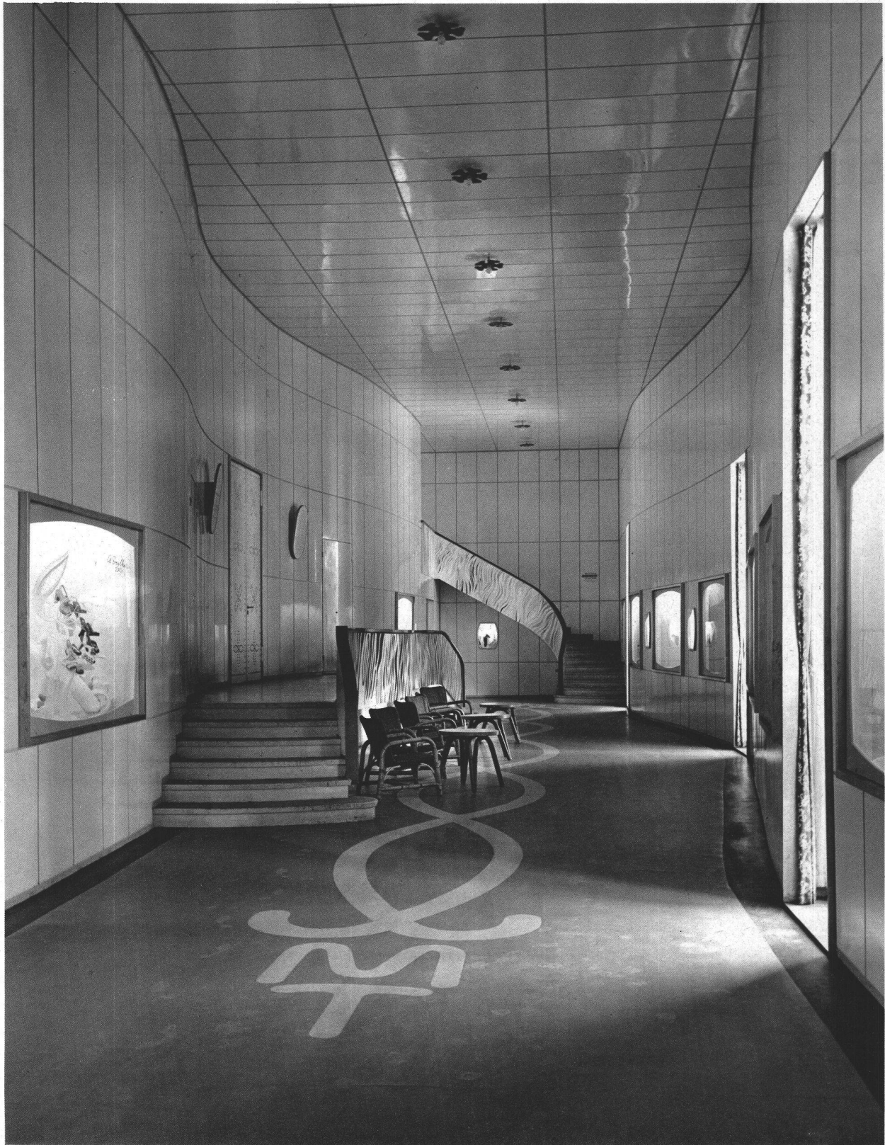
Modetheater der Schweiz. Landesausstellung Zürich 1939 Karl Egender, Arch. BSA, Zürich Foto R. Spreng SWB, Basel
