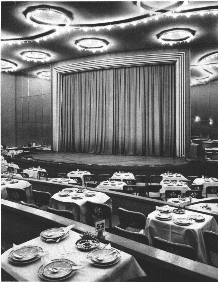
Modetheater der LA Zürich 1939 Karl Egender, Architekt BSA
