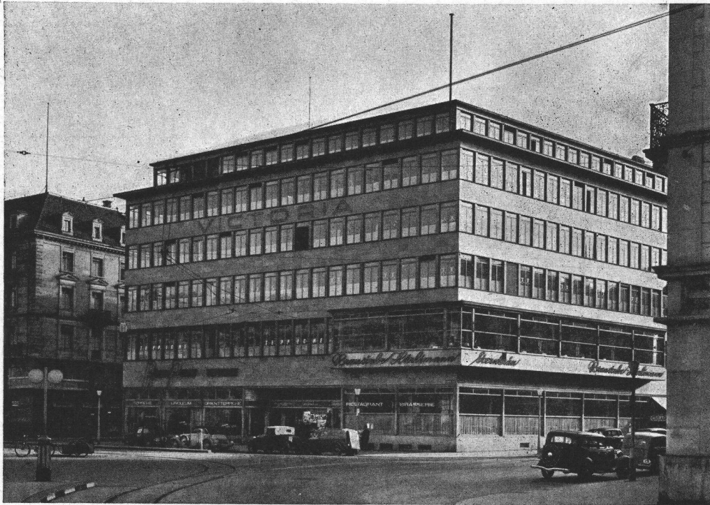
Stahltragwerk im Hochbau: Viktoria Zürich
