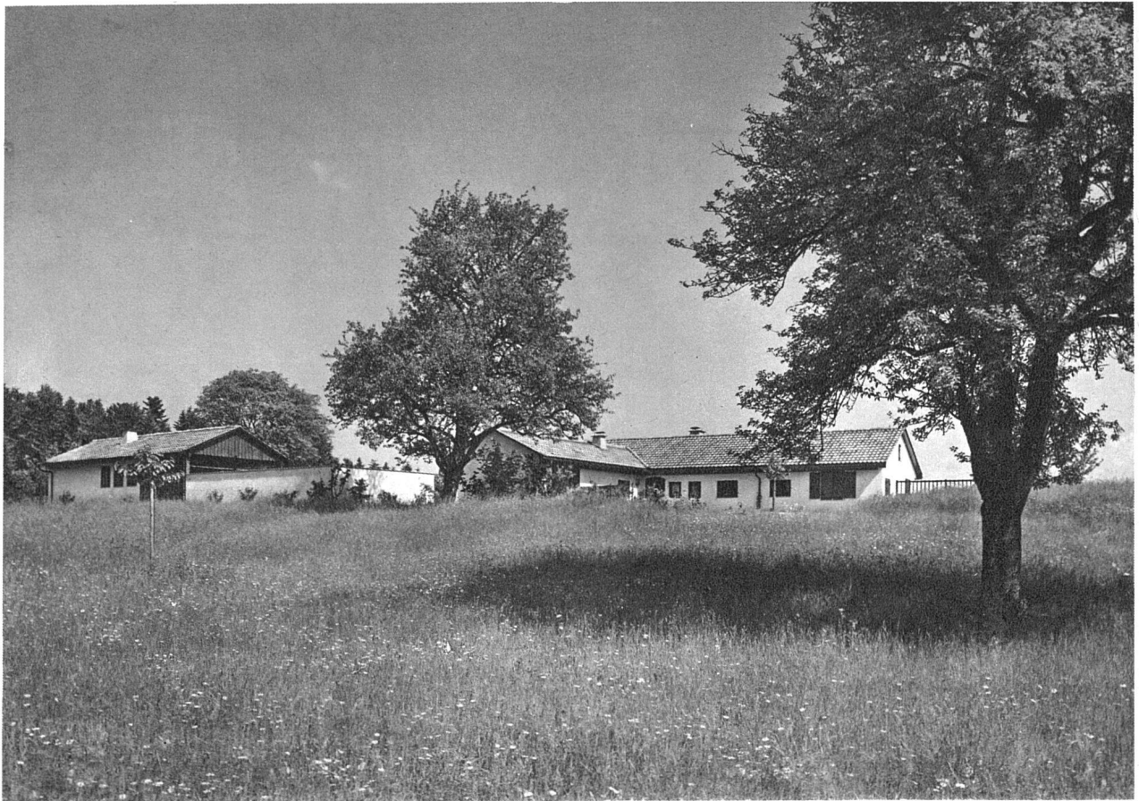
Ansicht von Nordwesten, rechts der Wohntrakt, links Wirtschaftstrakt
