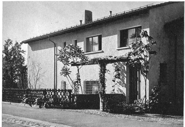
Haus vom Typ C, Eingang (Ostseite)
