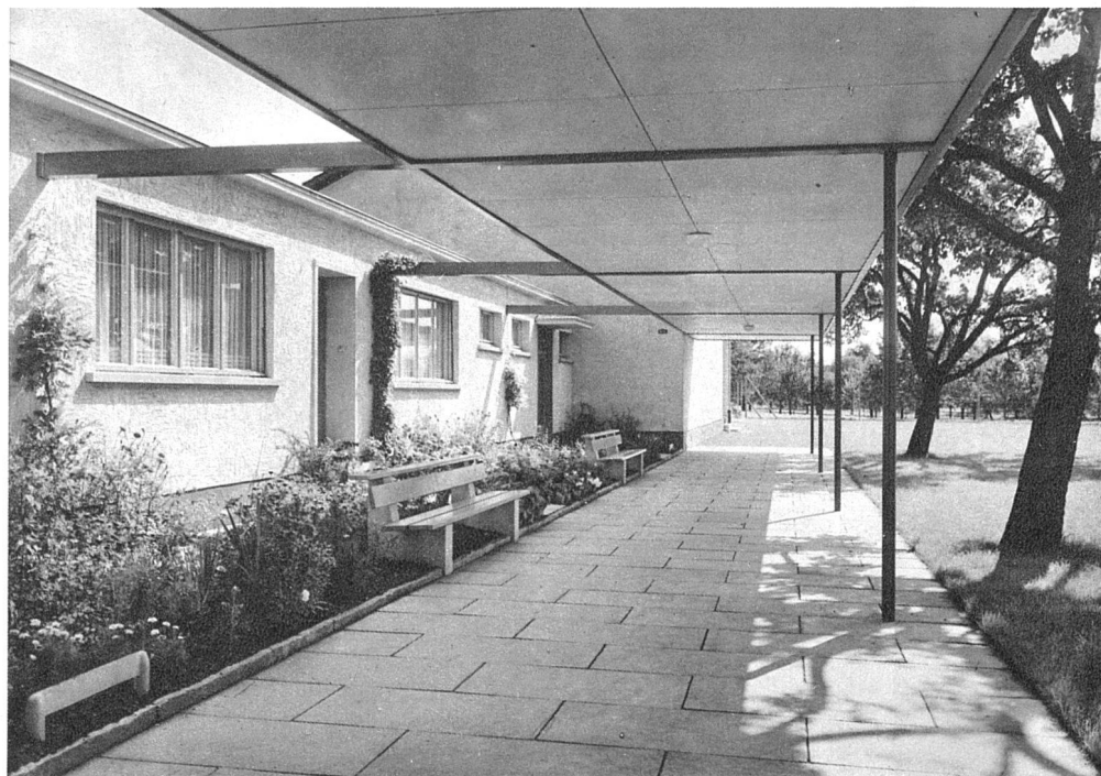
Pausenhalle, links Ab- wartwohnung, Blick nach Osten.
