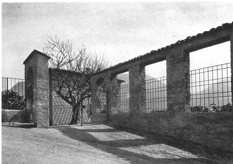
Ingresso al giardino. Muratura in pietrame intonacata rustica, inferriate e cancello in ferro verniciato verde-oliva
