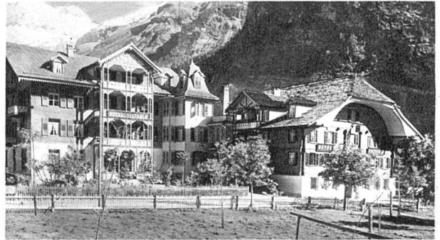
Halbstädtischer Neubau im «Chaletstil» mit Laubsäge-Dekoration ohne Verständnis für den echten, bodenständigen Holzbau.
