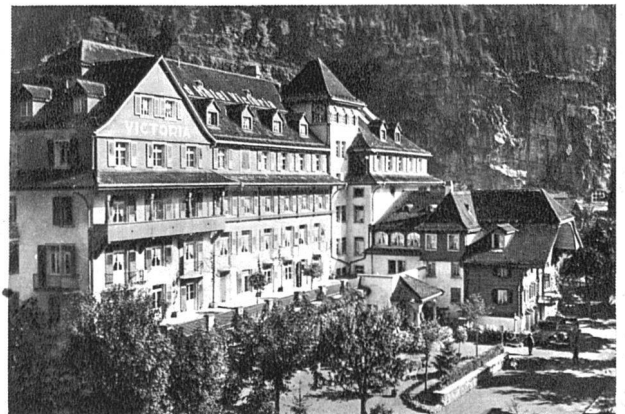
Unten: Man bemüht sich, bei der nochmaligen Aufstockung den ausgesprochen städtischen Charakter zu verwischen und die Substanzlosigkeit des Hauptbaus zu korrigieren.
