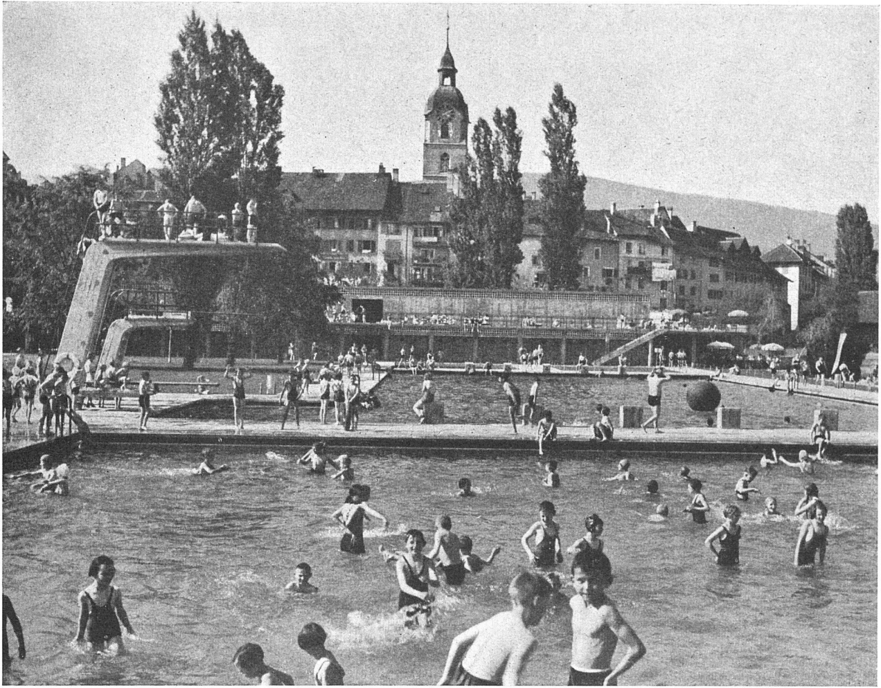
Schwimmbassins, Blick nach Norden auf die Altstadt
