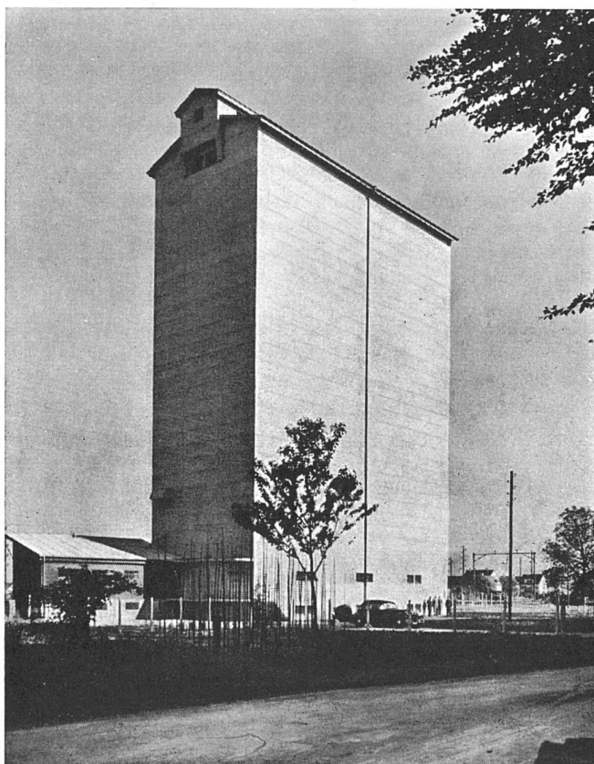
Neuer Silo der Neumühle Töb
