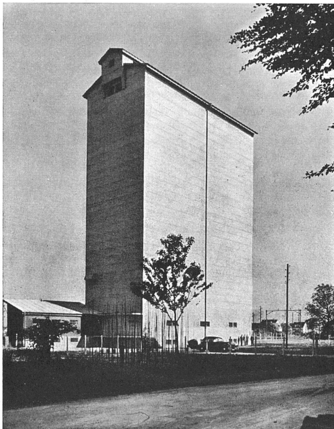
Neuer Silo der Neumühle Töb
