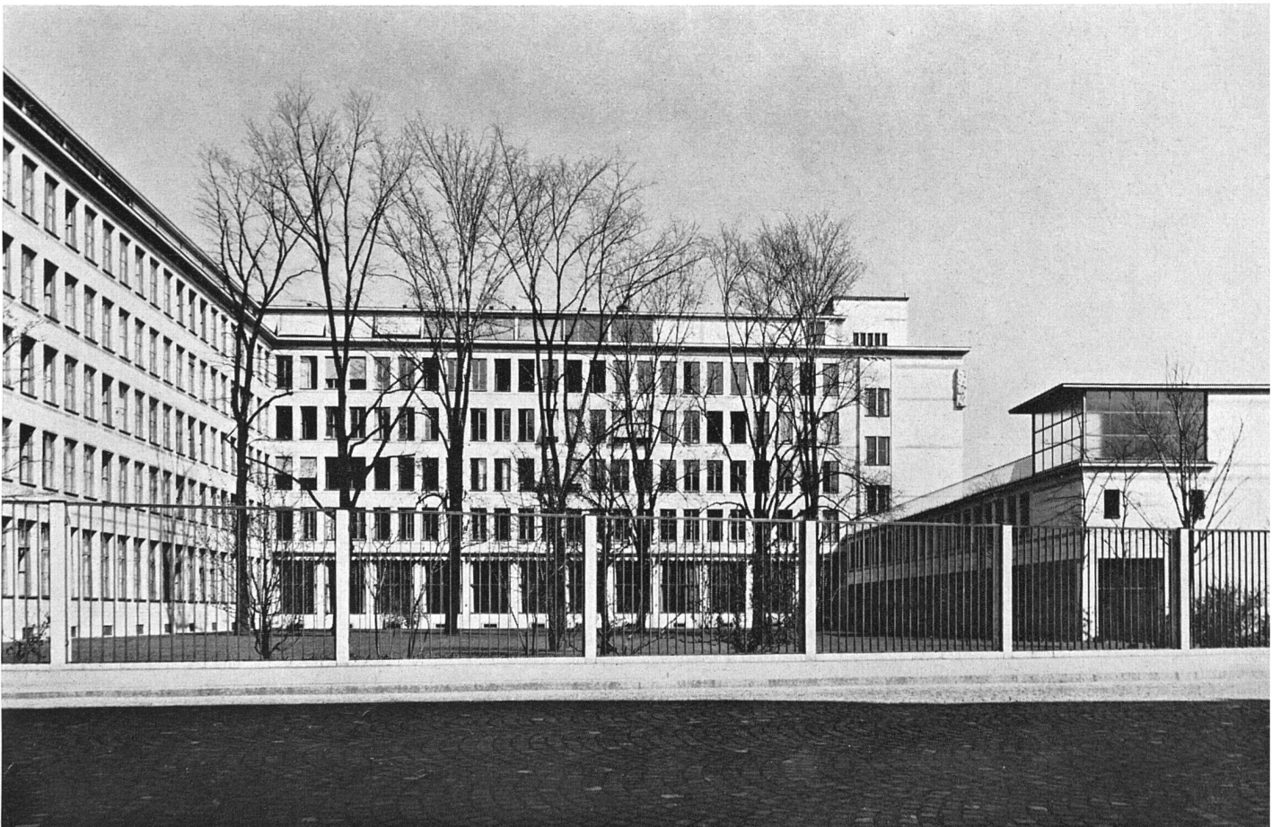
Ansicht von der Alfred Escherstraße, rechts oben Plastik O. Kappele
