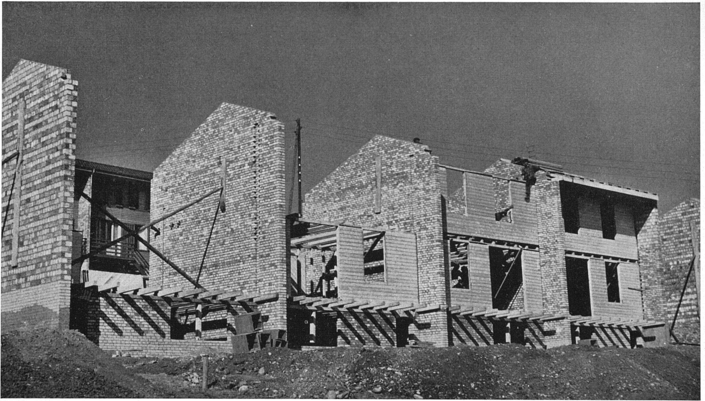
Die verschiedenen Etappen des Bauvorganges
