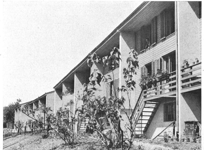
Die fertigen Bauten
