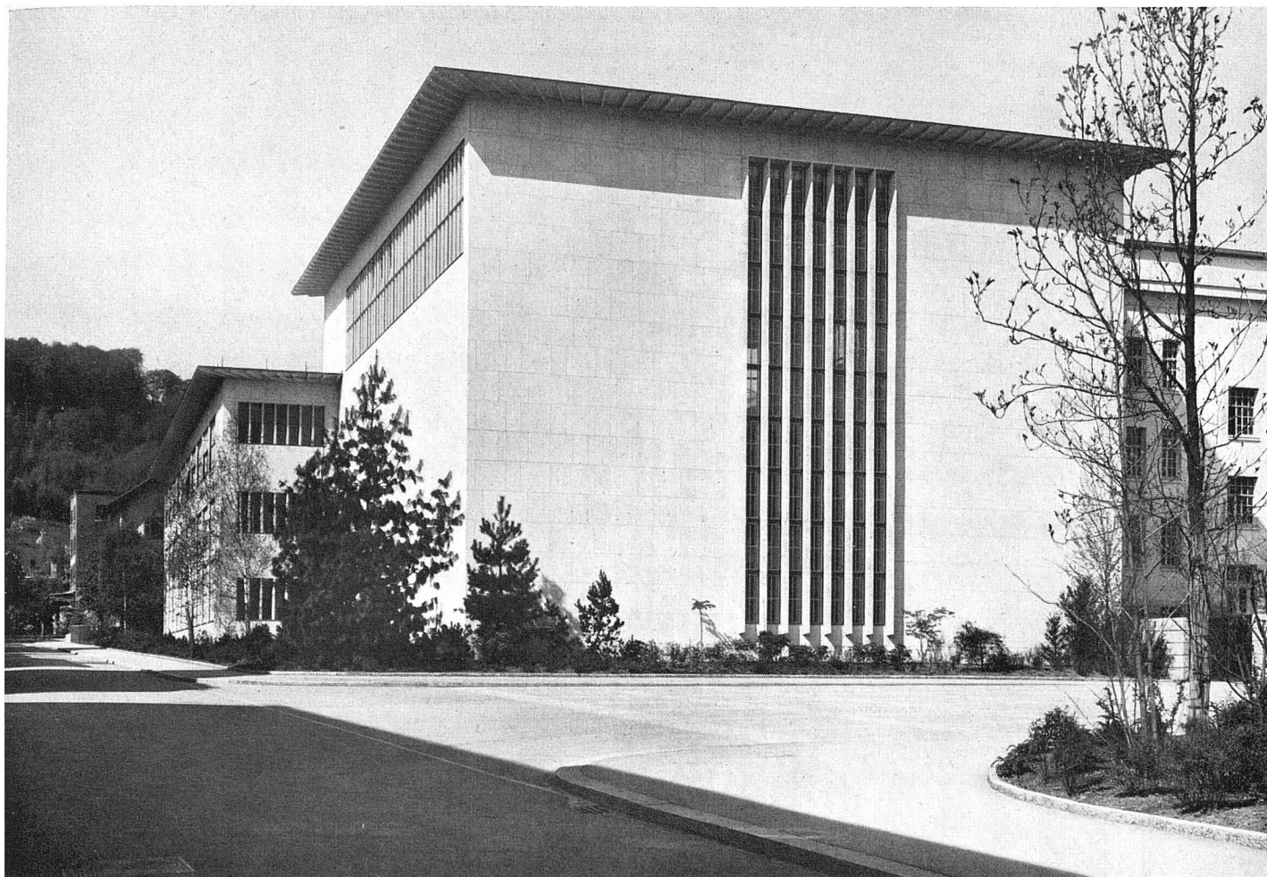
Das neue Hochspannungslaboratorium mit Vorhof
