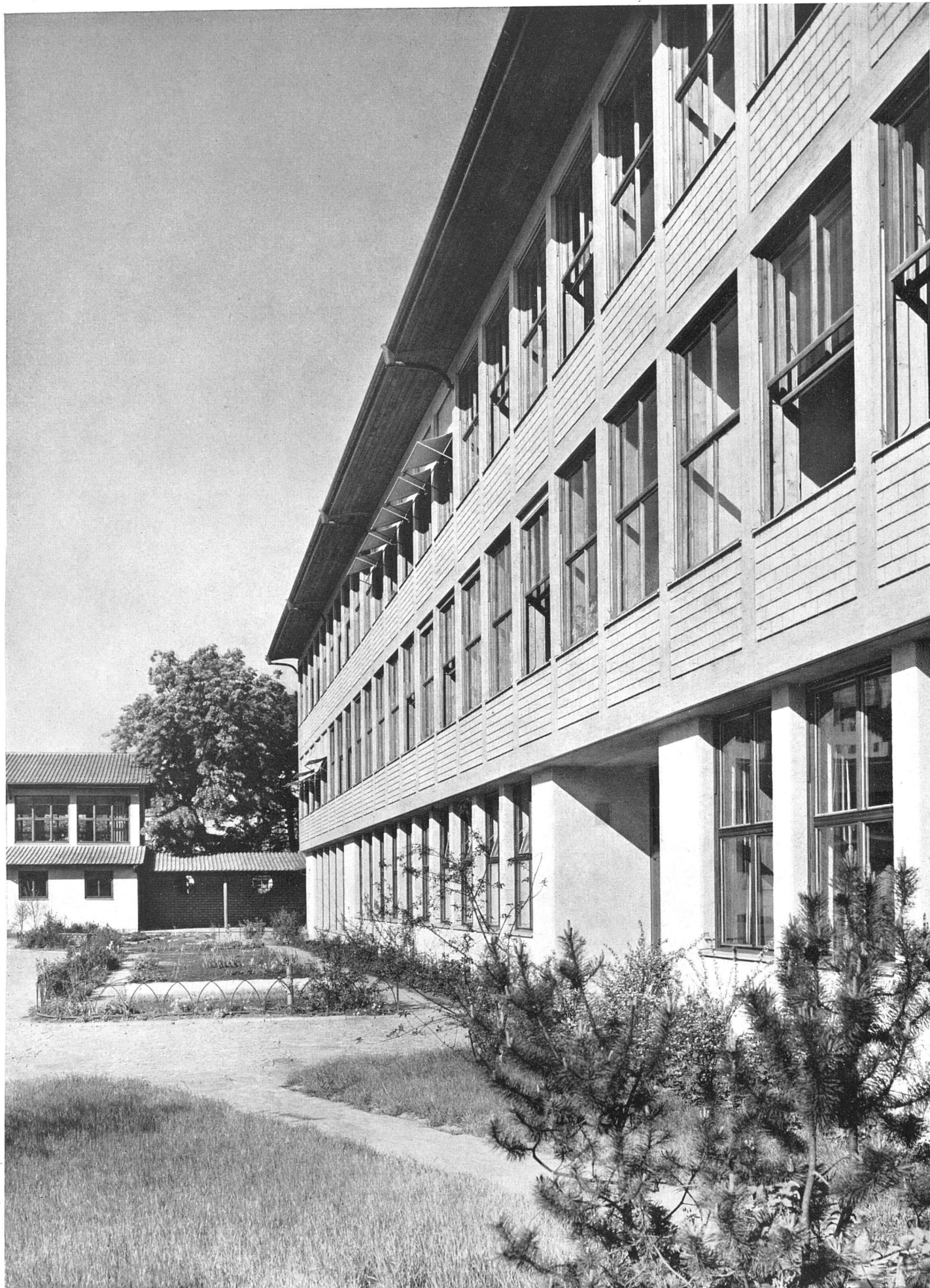
Hauptfront Klassentrakt mit Blick auf Pausen- und Turnhalle
