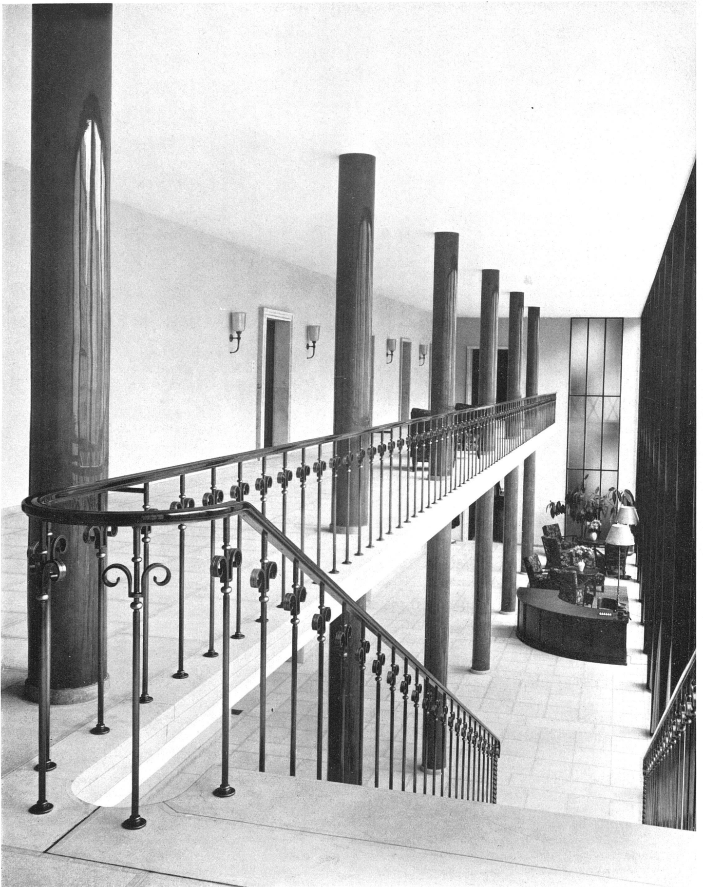
Empfangshalle. Bodenbelag in gelblichem Laufenerstein, Wände naturfarbener Putz, Säulen dunkelbrauner Stuck mit Hochglanz, Fensterrahmen in Mahagoniholz, Geländer in Bronze
