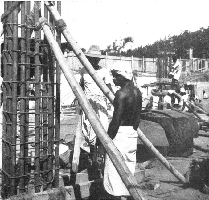
Stützenarmierung. Verstrebung mit Bambusstangen Transport des Betons durch Frauen
