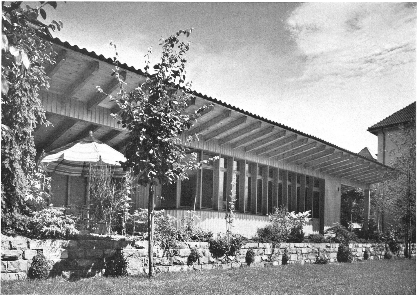
Gesamtansicht vom Garten gesehen
